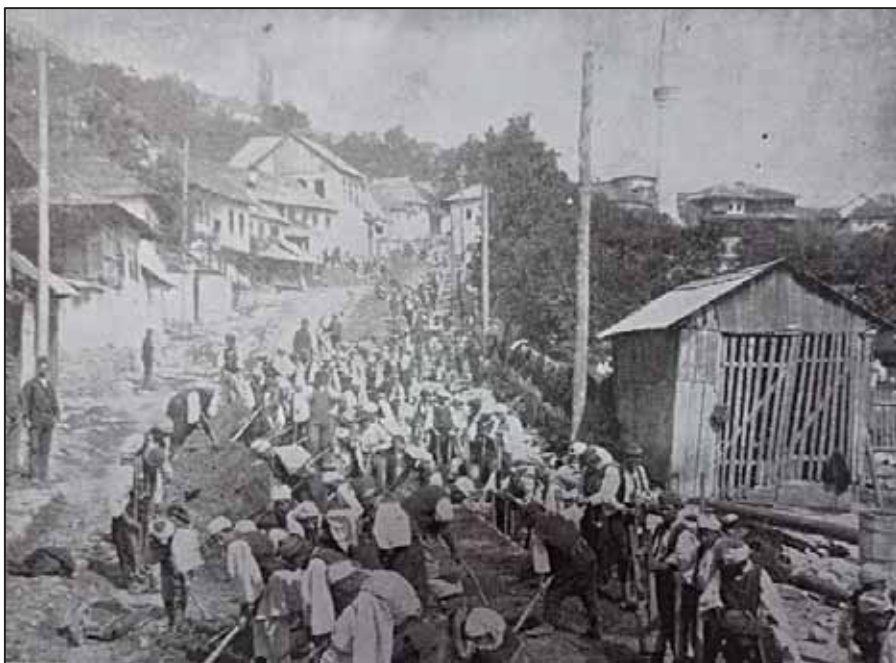
Prilog. 6. Polaganje cijevi novog vodovoda Mošćanica na Vratniku 1889. godine. 93
