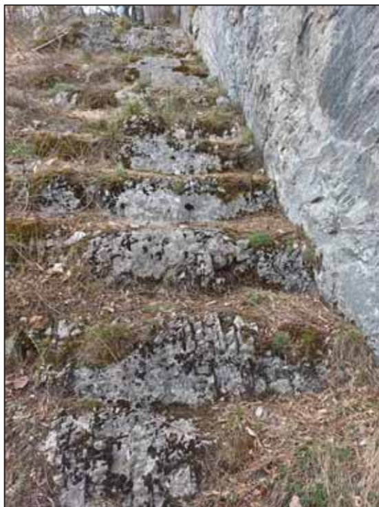
Prilog 5. Dio u kamenu uklesanih stepenica unutar Vrbenca. (snimio J. Topoljak, 2023. godine).
