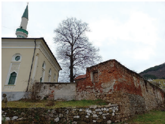
Prilog 14. Ostatak zida sjeveroistočnog krila.
