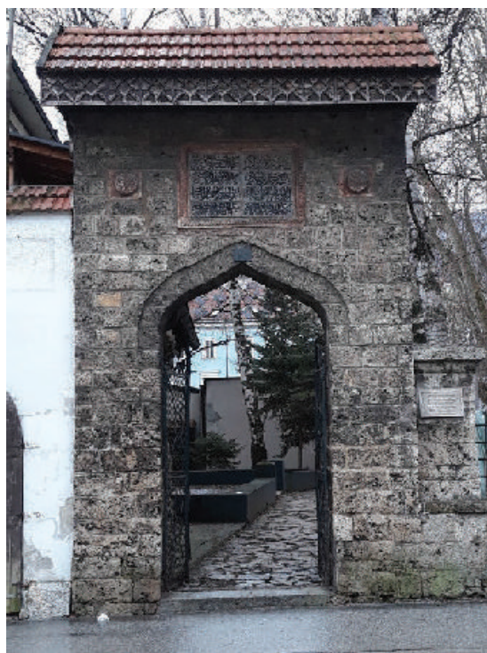
Prilog 9. Kapija za ulaz u nekadašnji kompleks medrese.
