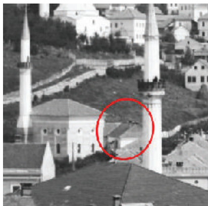
Prilog 13. Pogled na sjeveroistočno krilo
